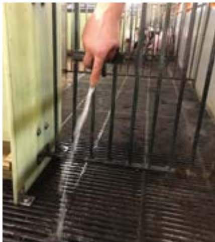
Spola rent vattenledningarna från gammalt vatten.
